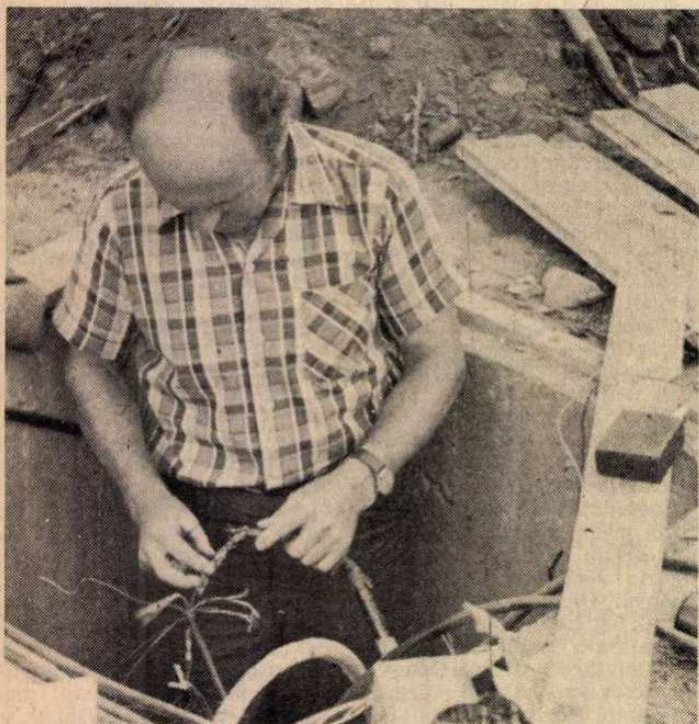
Bíró Bertalan az ERDÉRT alközpontjához csatlakozó 48 mellékállomás bekötésén dolgozik
